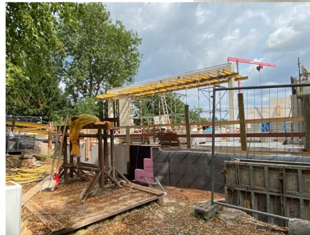
Einer der Unterzüge für die Saaldecke ist als Fertigteil montiert.
