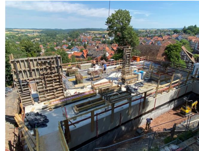
Die Decke über dem Untergeschoss ist gegossen, jetzt entstehen der Saal und die weiteren Räume des Erdgeschosses.
