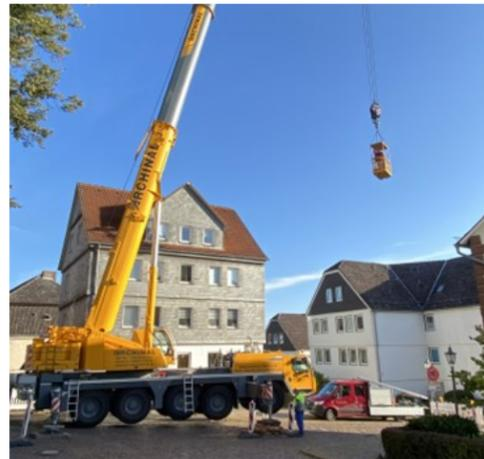
Am 27. September kam Udo Schmidt mit einem Gesellen, um mit Hilfe eines riesigen Kranwagens von Fa. Archinal die Schäden auf dem Dach des Chorraums zu reparieren. Die beiden Dachdecker ließen sich dazu in einem Korb am Seil des 60 m langen Auslegers jeweils genau zu den Schadstellen manövrieren, um die entsprechenden Arbeiten dort verrichten zu können.
